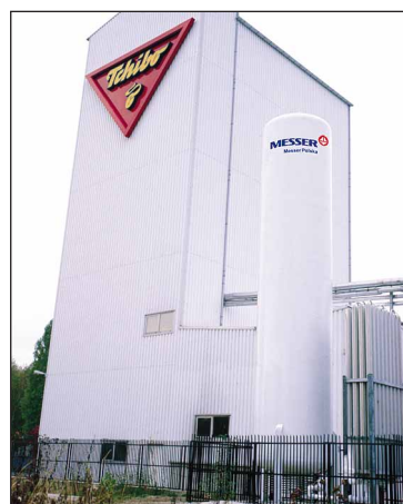
Ekonomiczne zaopatrzenie w ciekły azot wykorzystując stacjonarny zbiornik. Firma Tchibo - Marki k/Warszawy
