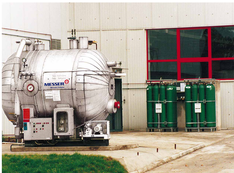
Zbiornik CO 2 oraz azot w wiązках butlowych do wytwarzania atmosfery ochronnej Inertal® w firmie Hochland Polska w Kaźmierzu Wielkopolskim
