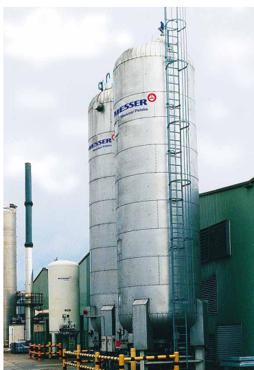
Zaopatrywanie w CO 2 i azot poprzez stacjonarne zbiorniki. Zakłady Napojów Gazowanych PEPSI COLI w Michrowie
