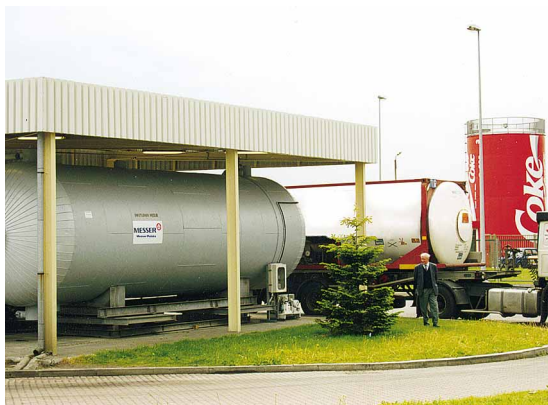
Zbiorniki magazynowe do przechowywania ciekłego dwutlenku węgla. Coca-Cola Radzymin
