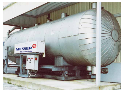
Pobór CO 2 ze zbiornika do nasycania wody mineralnej „Gerolsteiner” Rzeniszów
